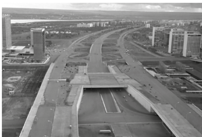
Início das obras, com a passarela de ligação já construída, 1965. Fonte: Arquivo Público do Distrito Federal
