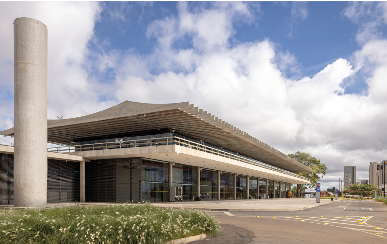
Edifício do SESI Lab SESI Lab building
