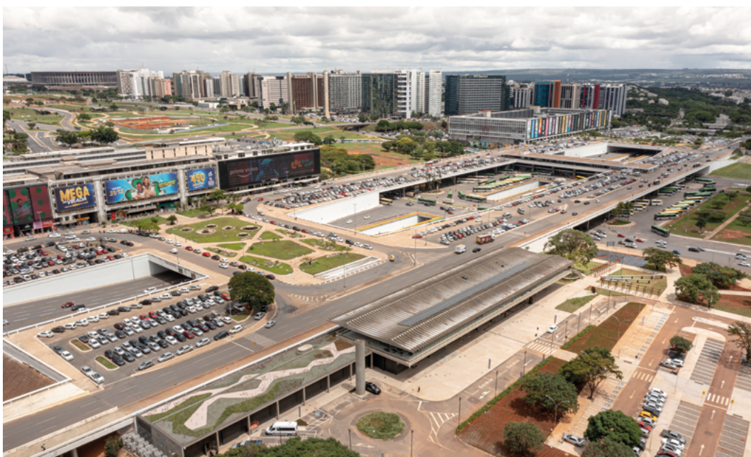
Vista aérea da área central de Brasília: SESI Lab, Rodoviária do Plano Piloto (à direita) e o conjunto do CONIC - Setor de Diversões Sul (à esquerda e no alto). Foto: Joana França
